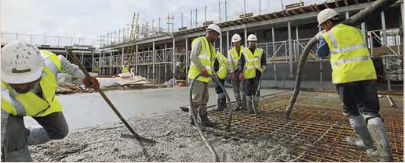
I Derby pågår bygget av det nya sjukhuset som ska drivas i offentlig-privat samverkan, i Storbritannien kallat PFI. Skanska BOT innehar hälften av ägarkonsortiet och Skanska UK har hela uppdraget att utforma och bygga sjukhuset, värt GBP 333 miljoner. Första hälften av det 155 000 kvm stora projektet ska stå klar 2006.
