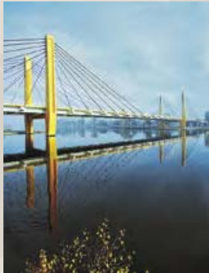
Millennium-bron över floden Oder ingår i en ny vägled förbi Wrocław i Polen. Bron är totalt 972 m lång varav den centrala hängbron är 290 m. Pylonerna är 50 m höga. Projektet färdigställdes på mindre än tre år.
