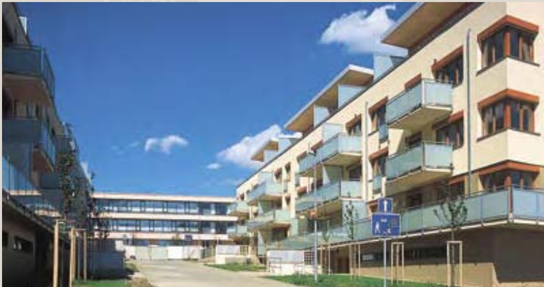
Botanica i Prag är ett nytt bostadsområde som har utformats med tanke på bra miljö och låg energiförbrukning. Bostadsområdet ligger i anslutning till en naturpark. Hundratals träd bidrar till trivseln. Botanica rymmer fyra flerfamiljshus med 124 lägenheter samt 20 rad- och kedjehus.
