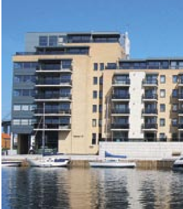
Fyra framgångsrika etapper har slutförts i Stavanger-projektet Badedammen. Det intilliggande havet bjuder på såväl utsikt som rekreativsmöjligheter och uppvärmning.
