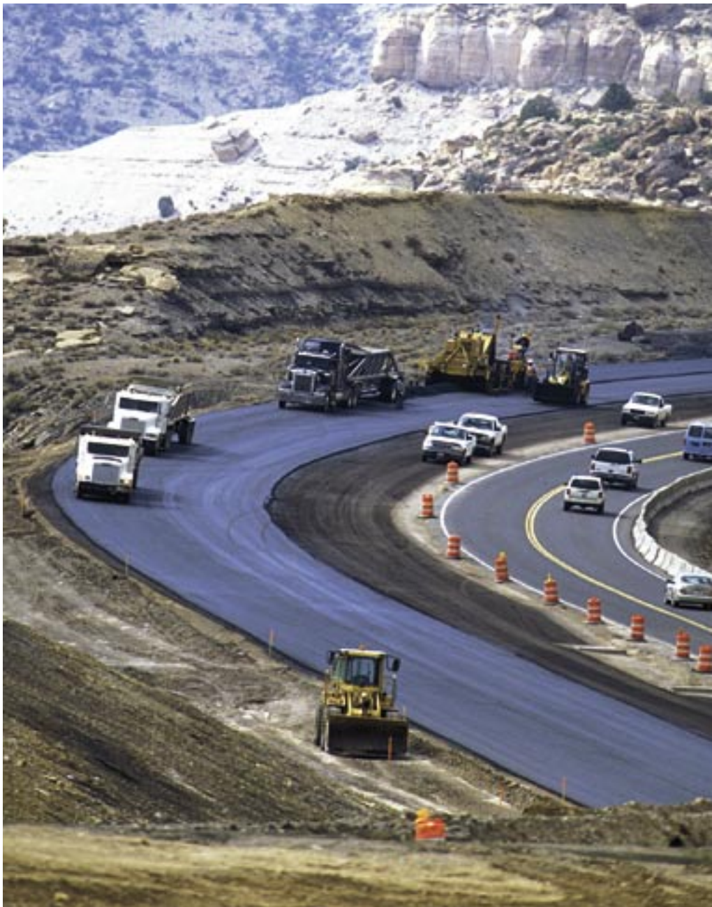
Motorväg U.S. Route 50, Colorado, USA
