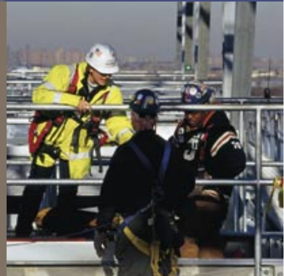
Kraftverket Charles M. Poletti Generating Station, New York, USA
