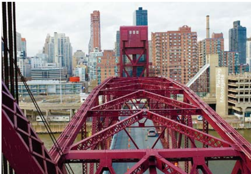
Roosevelt Island är en liten ö i East River i New York. Med bil nås ön endast via den höj- och sänkbara vägbron från 1955. Bron mellan Queens och Roosevelt Island har nu fått en grundlig renovering av Skanska som fick uppdraget baserat på sin brokompetens och inte på pris. Renoveringen slutfördes två månader före tidplan.
