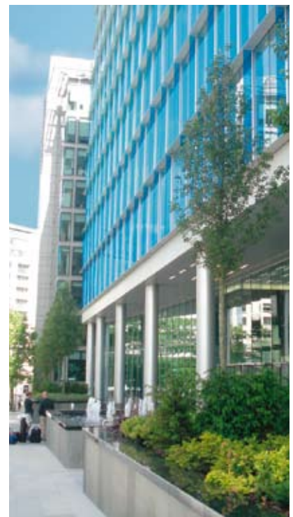
One Kingdom Street vid Paddington-Central i London utnyttjar såväl bergvärme som solpaneler för att reducera klimatpåverkan.
