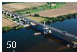
50 Utbyggnad av den andra etappen av A1 i Polen
