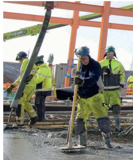
Som mest arbetar 1 500 personer med byggandet av Nya Karolinska Solna, Stockholm.
