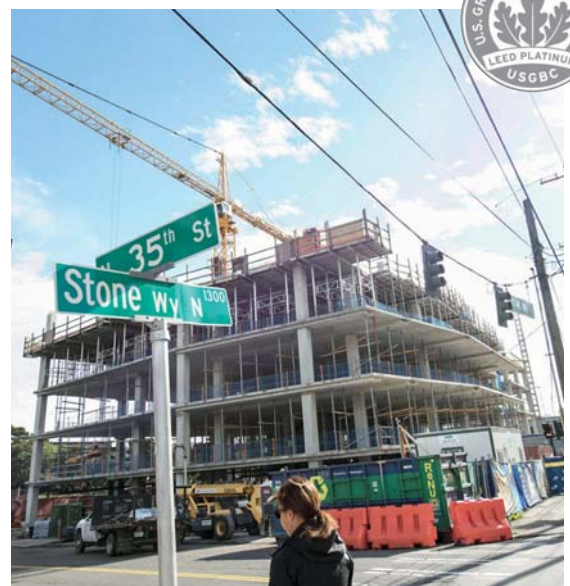
Stone34 – utvecklat av Skanska för Brooks Sports – är det första kommersiella fastighetsprojektet och den andra byggnaden hittills som deltar i Seattles "Living Building Pilot Program".
