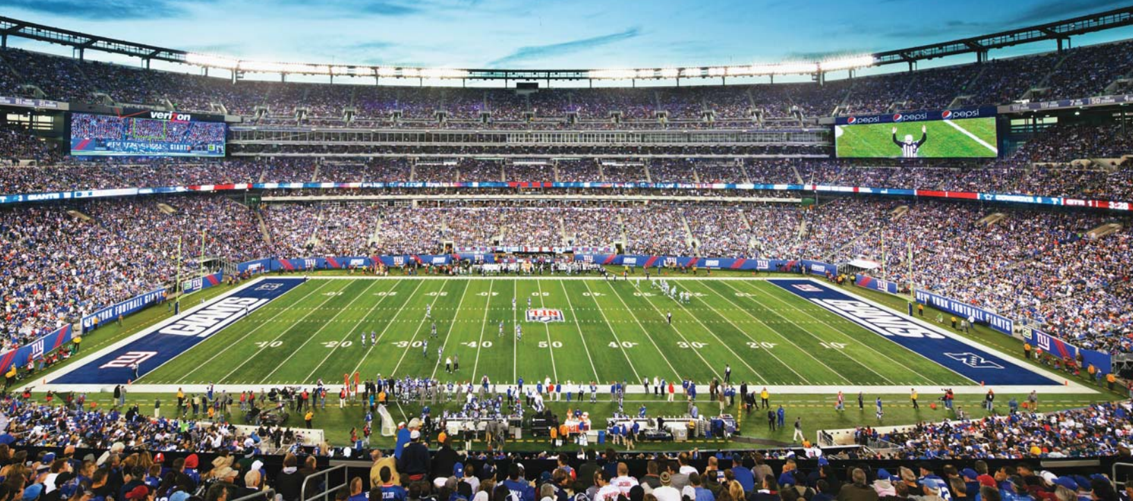
MetLife Stadium, New Jersey, USA. Skanskas höga etiska målsättning var avgörande för kundens val av Skanska som leverantör av den nya stadion.
