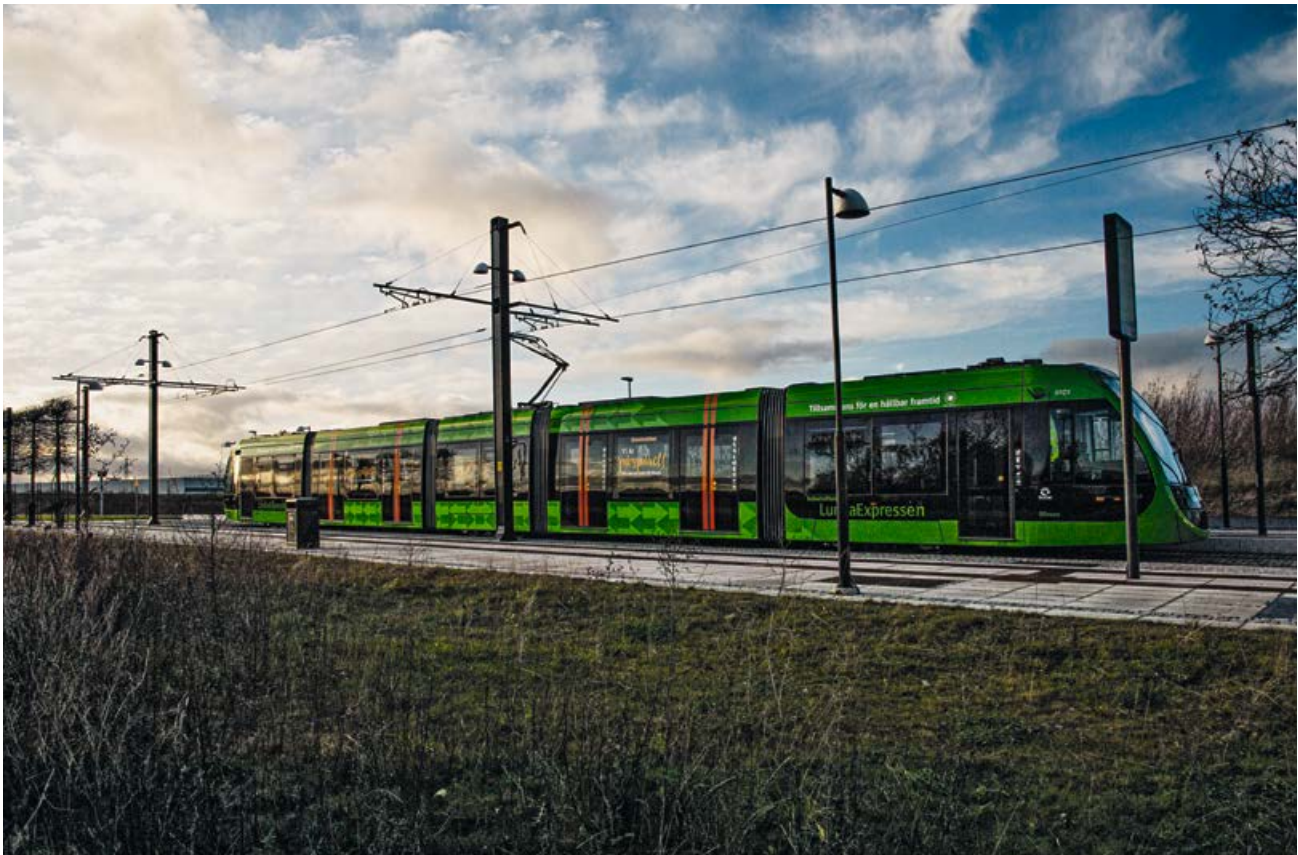
Den nya spånvägslinjen som Skanska byggt förbinder ESS med Lunds centrum.
