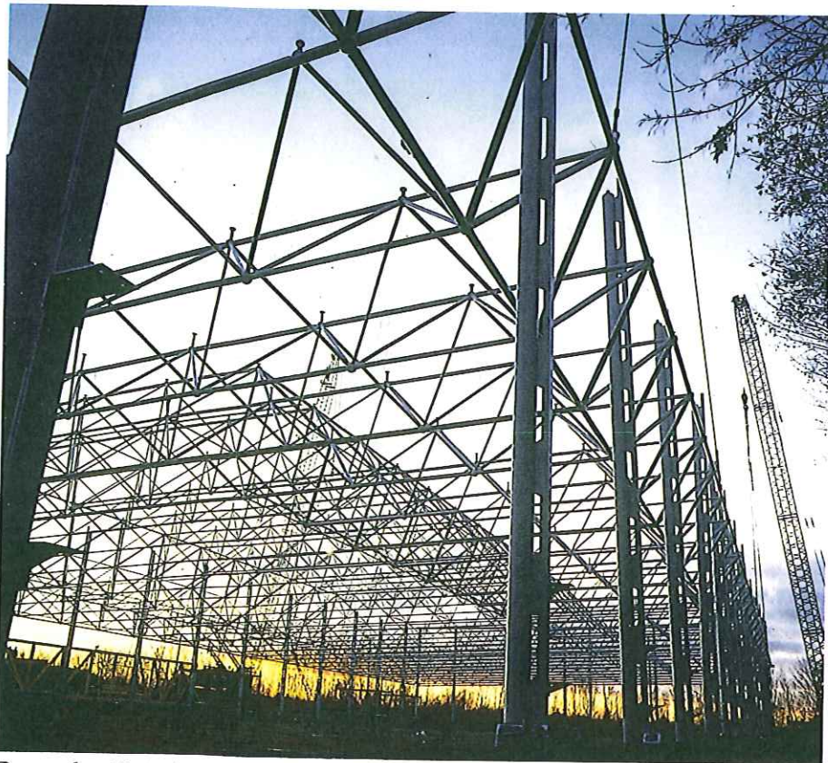
Danmarks största inomhusarena för tennis. Takkonstruktionen mäter 3 500 kvm.
