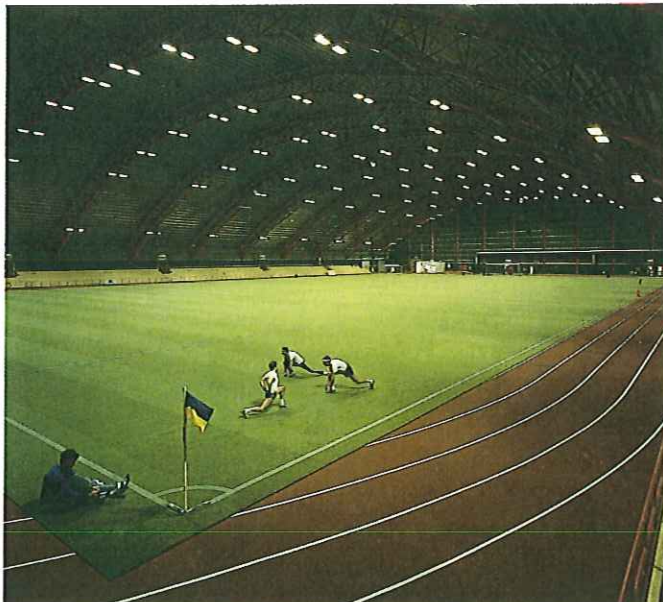
Arcus-hallen Luleå, ett konsortiebygge på totalentreprenad.
