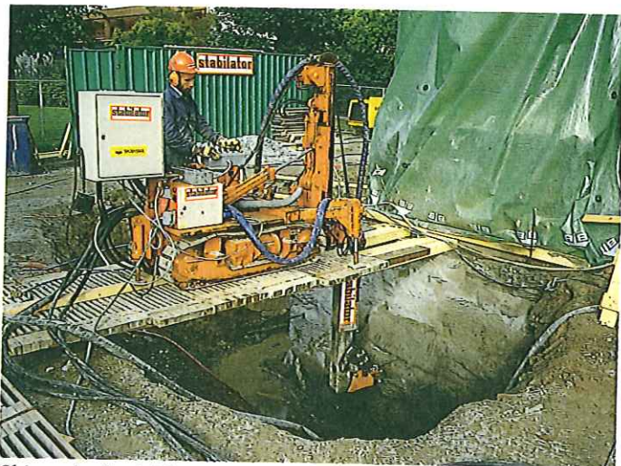
Skiens kyrka i Norge grundförstärks genom Rot-fyllning, en helt ny metod som utvecklats av Stabilator.
