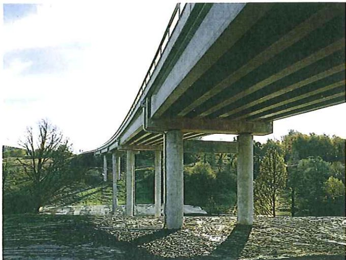
Betongelementsystem i prefab gör ett brobygge både snabbt och billigt. Ovan ses bron över Säveån i Lerum.
