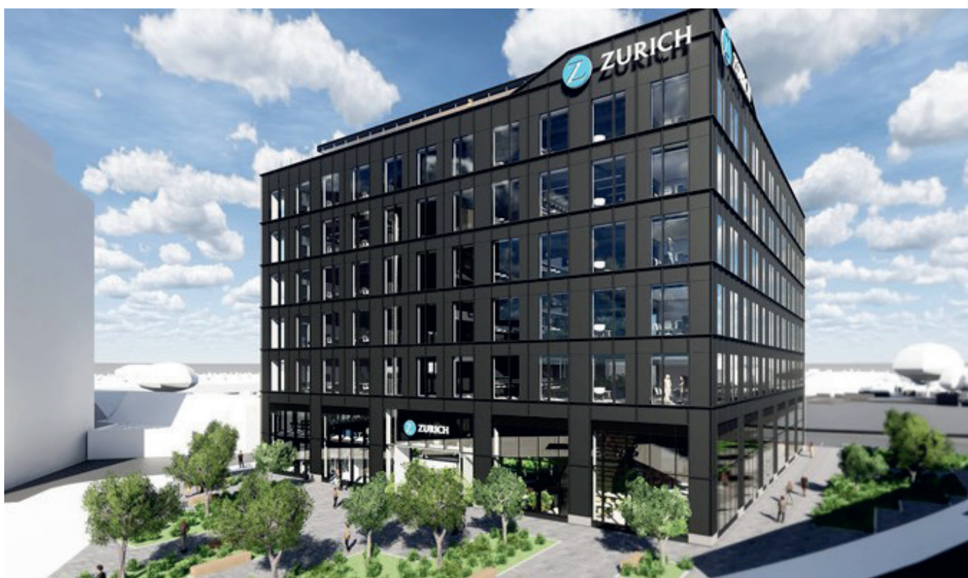
Kommersiell kontorsfastighet, Swindon, Storbritannien
