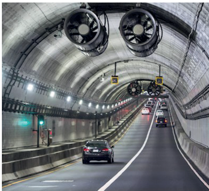
Försäljning, Elizabeth River Crossings, Virginia, USA
