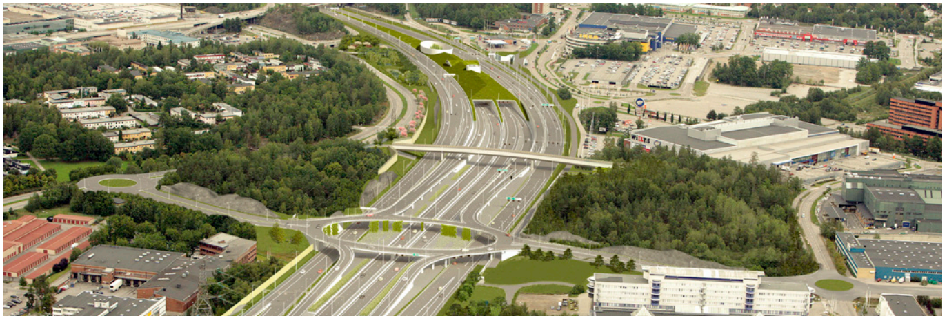
Tunnel, Förfärd Stockholm, Kungens Kurva, Sverige.
