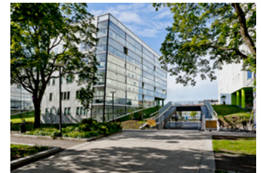
Uppsala Entré, Sweden.
