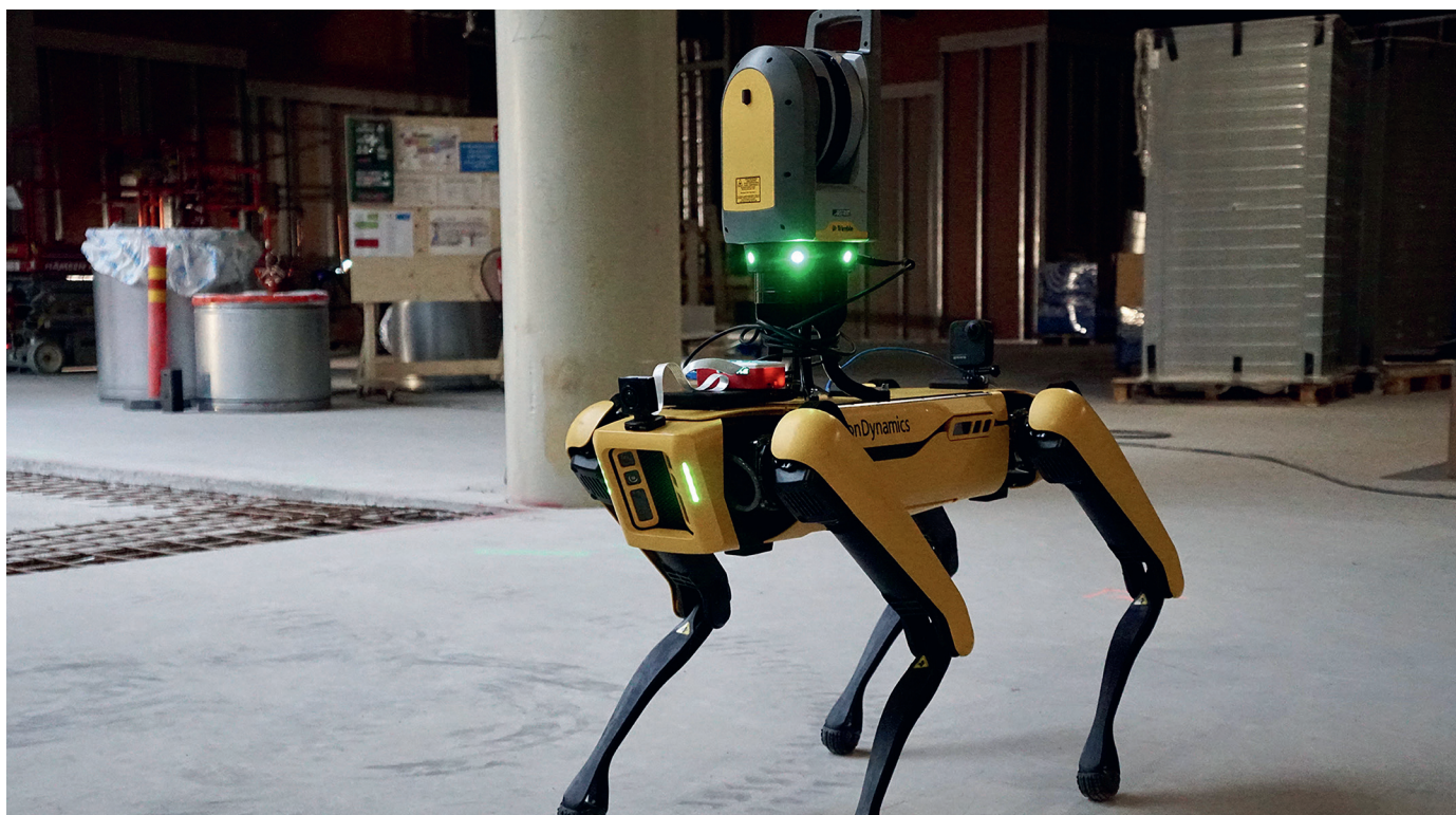
Robothunden Spot besökte Skanskas byggarbetsplats Lippulaiva shoppingcenter i Esbo, Finland som en del av Building 2030 konsortiets testaktiviteter med syfte att undersöka möjligheterna att använda robotteknik för projektledning. Building 2030 konsortiet, där Skanska ingår, utvecklar en vision för den finska byggbranschen 2030 som ett sätt att förbereda sig på förändringar inom branschen för att säkerställa en mer hållbar byggbransch i framtiden. Bild: AE Partners.
